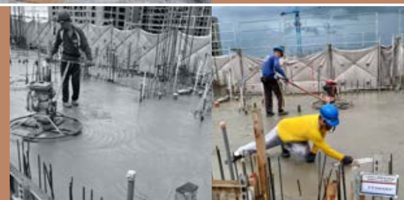
粉光工程 防止裂縫滲水
