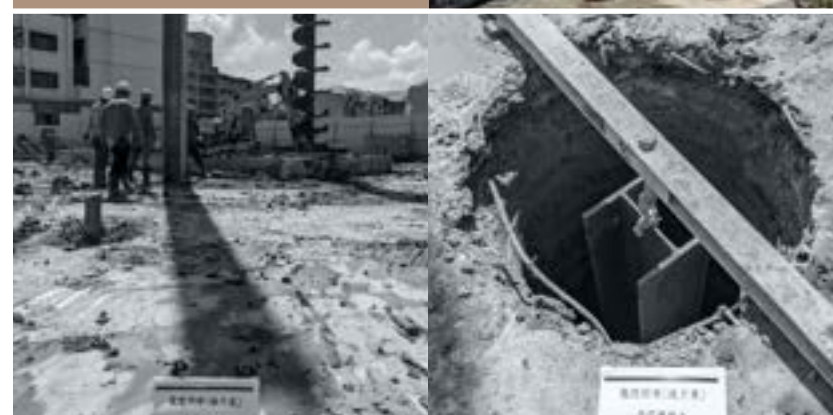
中間樁及 共構樁根固
