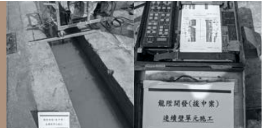
壁體 超音波檢測
