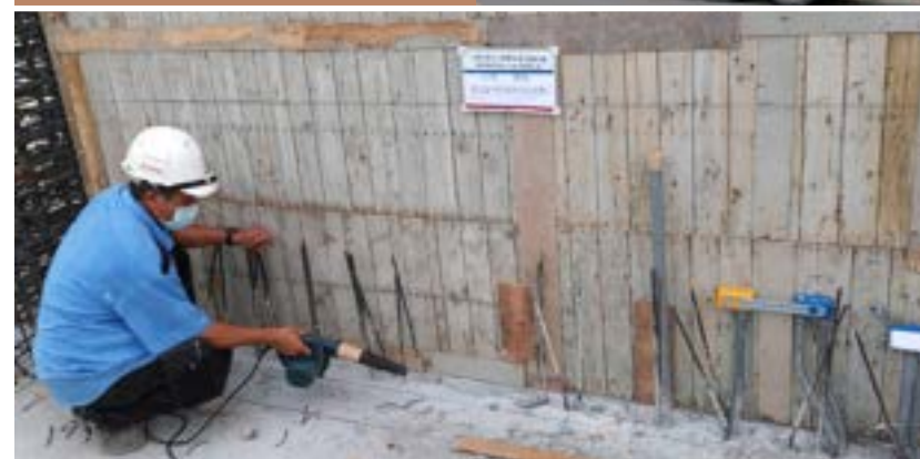
混凝土交界 面粉塵清掃
