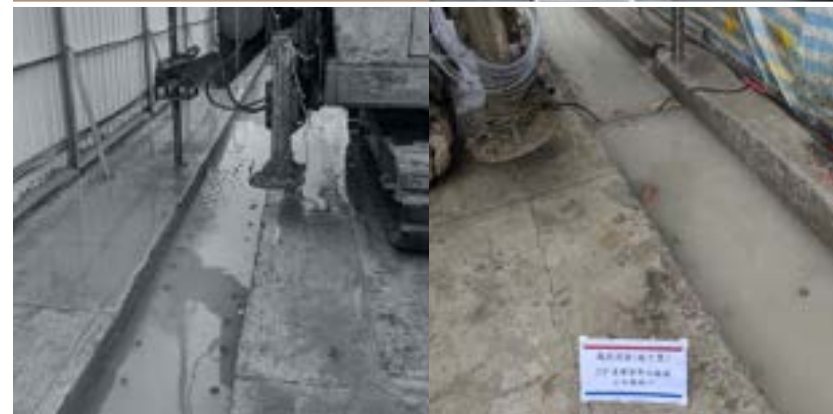
連續壁 端部CCP止水樁
